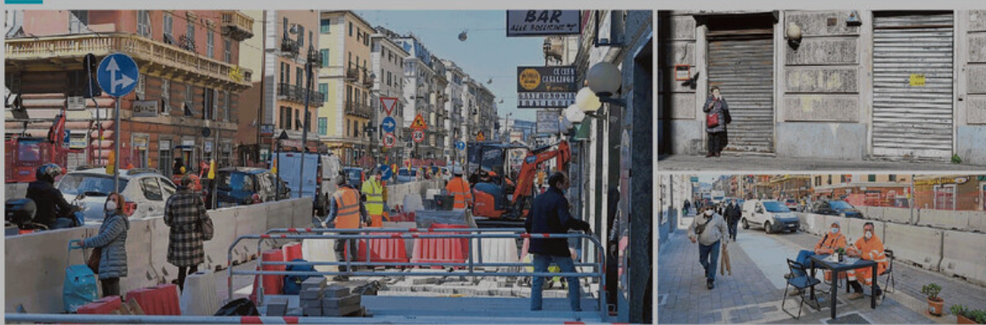
Sopra, pedoni e negozi costretti a convivere con il cantiere; a destra in alto serrande chiuse sulla strada, sotto primi tavolini fuori dal bar Chicchi d'autore
